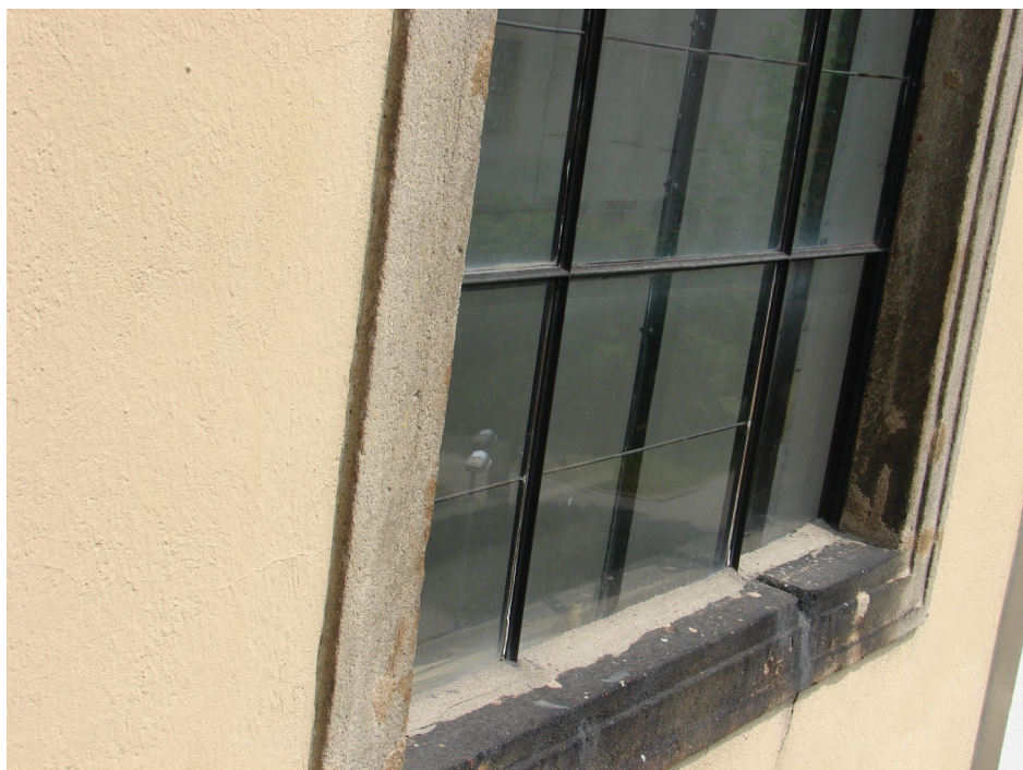
Detail pískovcového ostění okna na jižní straně kostela, druhé okno od východního nároží.
