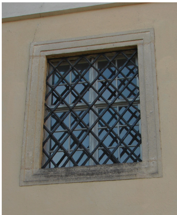
Pískovcové ostění okna do zákristie, východní strana, horní řada, okno č. 5.
