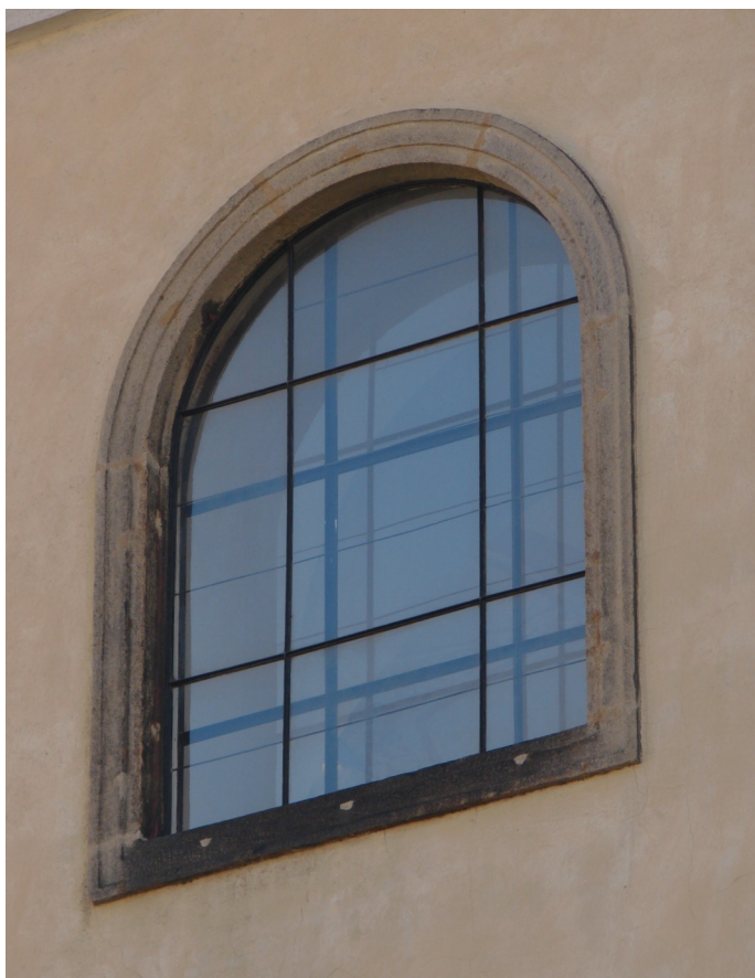
Pískovcové ostění okna na jižní straně kostela, druhé okno od východního nároží.
