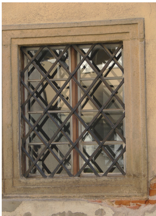
Pískovcové ostění okna do zákristie, v dolní řadě, severní strana, okno č. 4.
