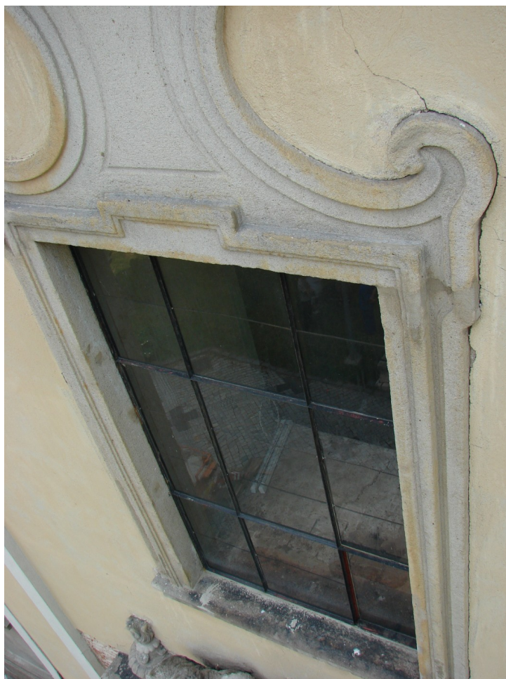
Detail dolní části ostění okna s výrazným znečištěním.
