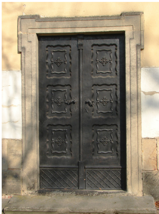
Pískovcové ostění bočního vstupu do budovy, jižní strana kostela.
