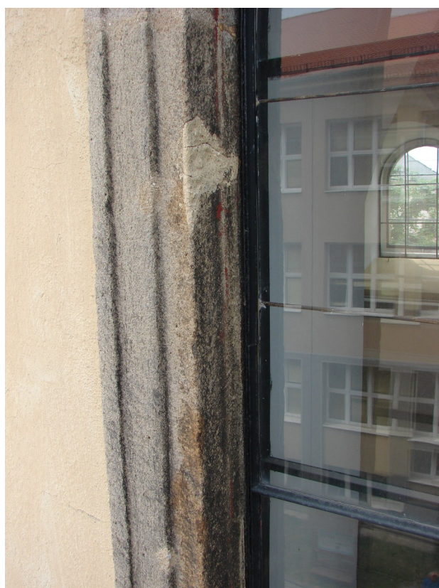
Detail levé strany ostění s výrazným defektem, (čtvrté okno od nároží), na severní straně kostela.
