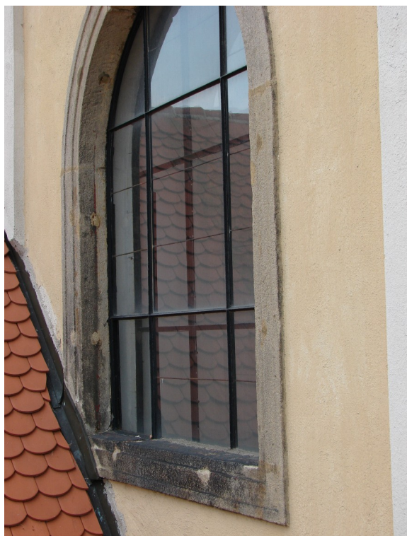
Pískovcové ostění okna na severní straně lodi kostela, (páté okno od nároží), částečně překryté střechou zákristie.
