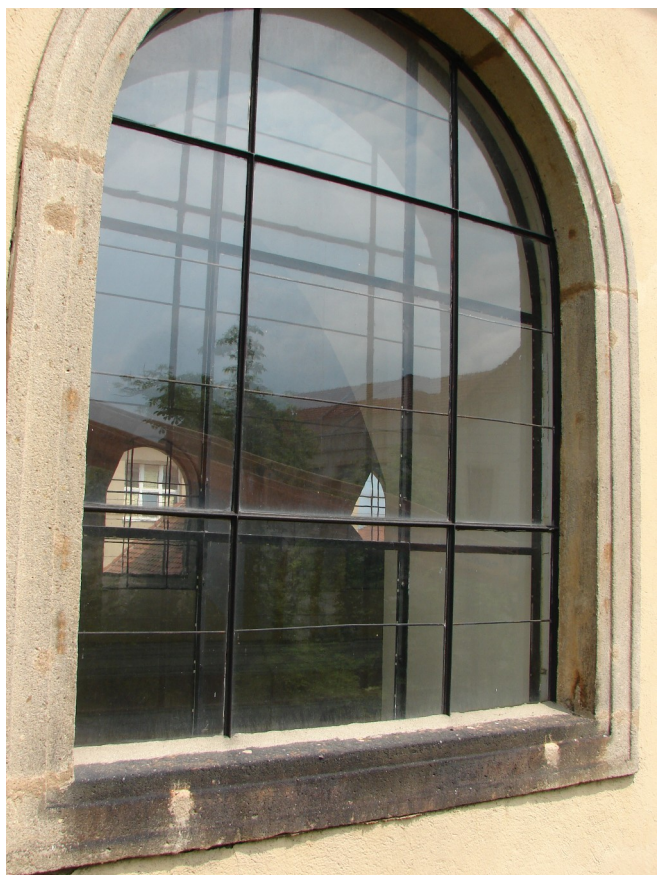
Pískovcové ostění okna na jižní straně kostela, první okno od východního nároží.
