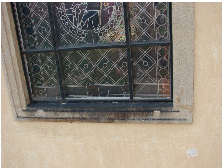
Detail spodní části ostění okna na severovýchodní straně kostela s výraznou krustou, ( první okno od zákristie).
