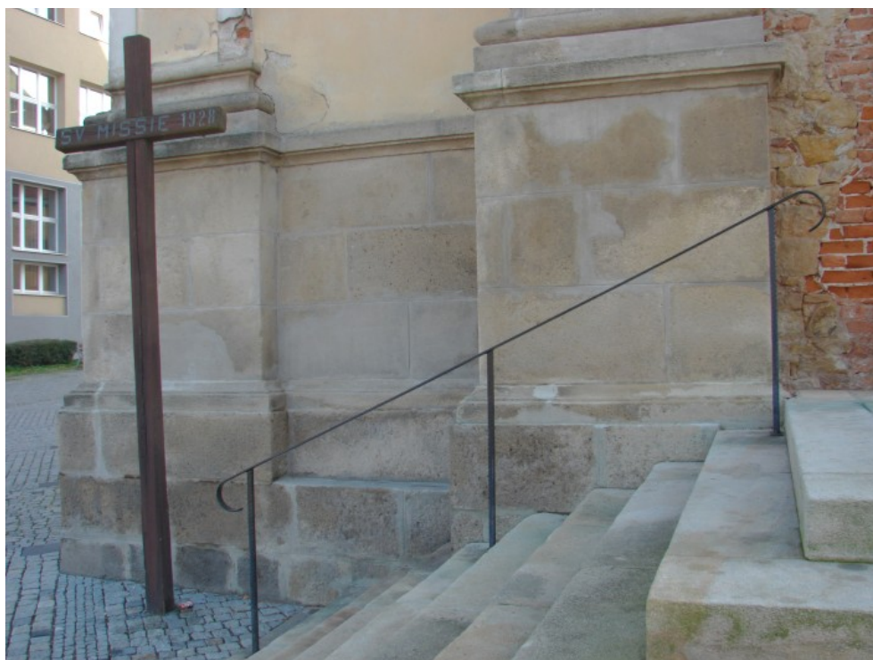
Pískovcové obložení nároží kostela, západní strana budovy - pravá strana od hlavního vstupu.
