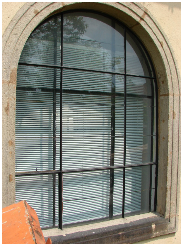
Pískovcové ostění okna na jižní straně kostela, páté okno od východního nároží.
