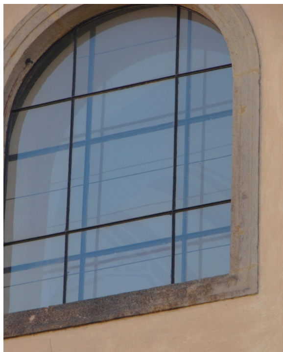
Pískovcové ostění okna na severní straně kostela, ( čtvrté okno od nároží).
