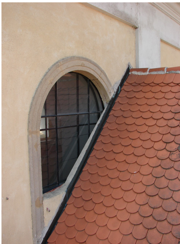
Pískovcové ostění okna na severní straně kostela, (šesté okno od nároží), které je částečně překryto střechou od zákristie.
