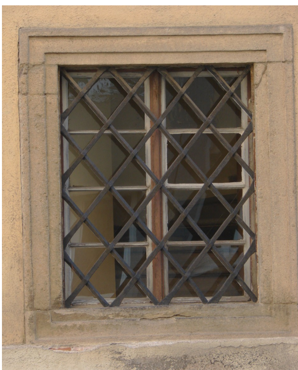
Pískovcové ostění okna do zákristie, v dolní řadě, severní strana, okno č. 3.
