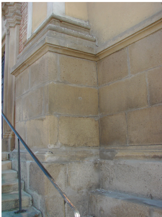
Pískovcové obložení nároží kostela, západní strana budovy - pravá strana od hlavního vstupu.
