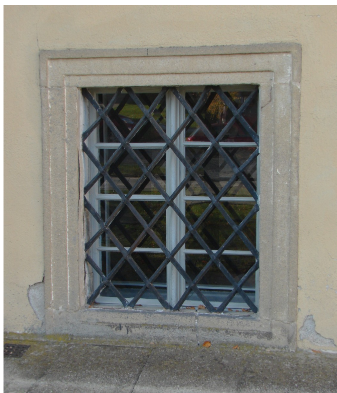
Pískovcové ostění okna do zákristie, východní strana, okno č. 6.
