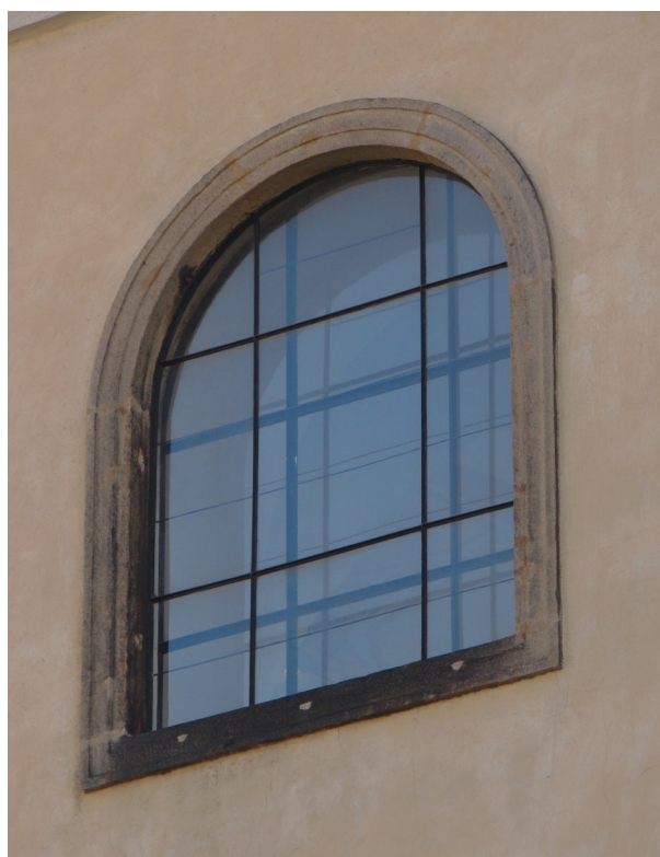
Pískovcové ostění okna na levé straně kostela, (druhé okno od nároží).
