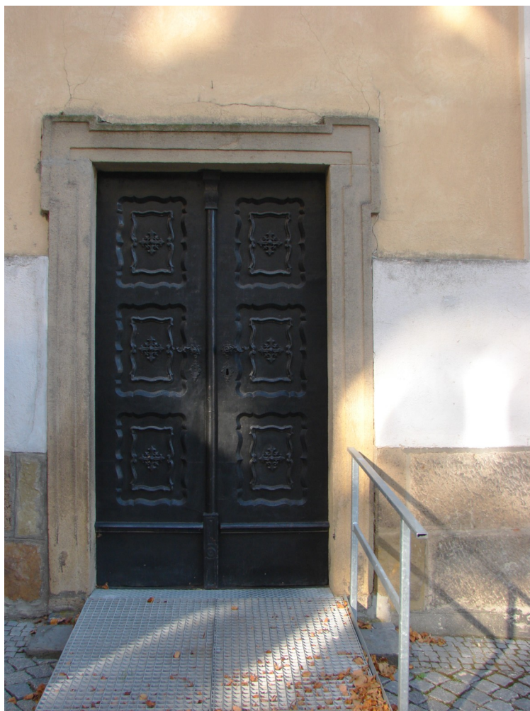
Pískovcové ostění bočního vstupu do budovy – severní strana.
