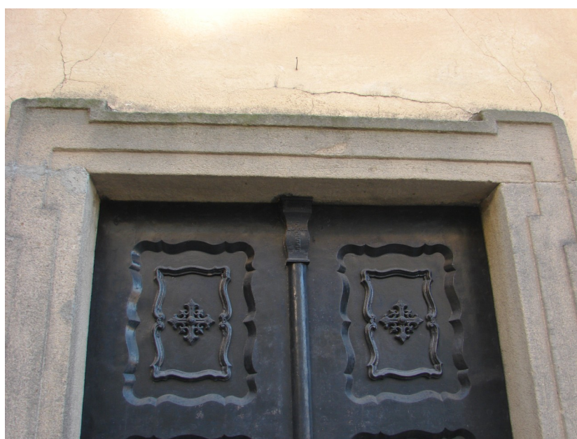
Detail horní části pískovcového ostění vstupu do kostela – severní strana.
