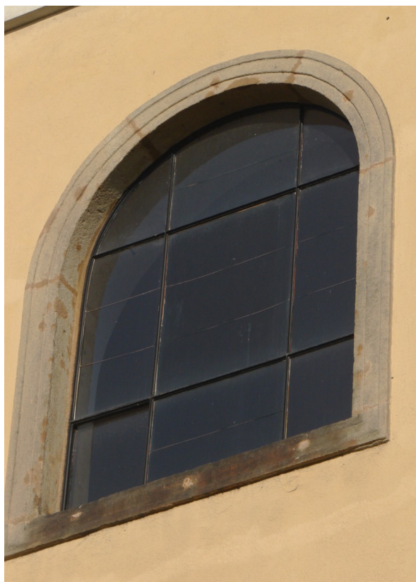
Pískovcové ostění okna na jižní straně kostela, šesté okno od východního nároží.
