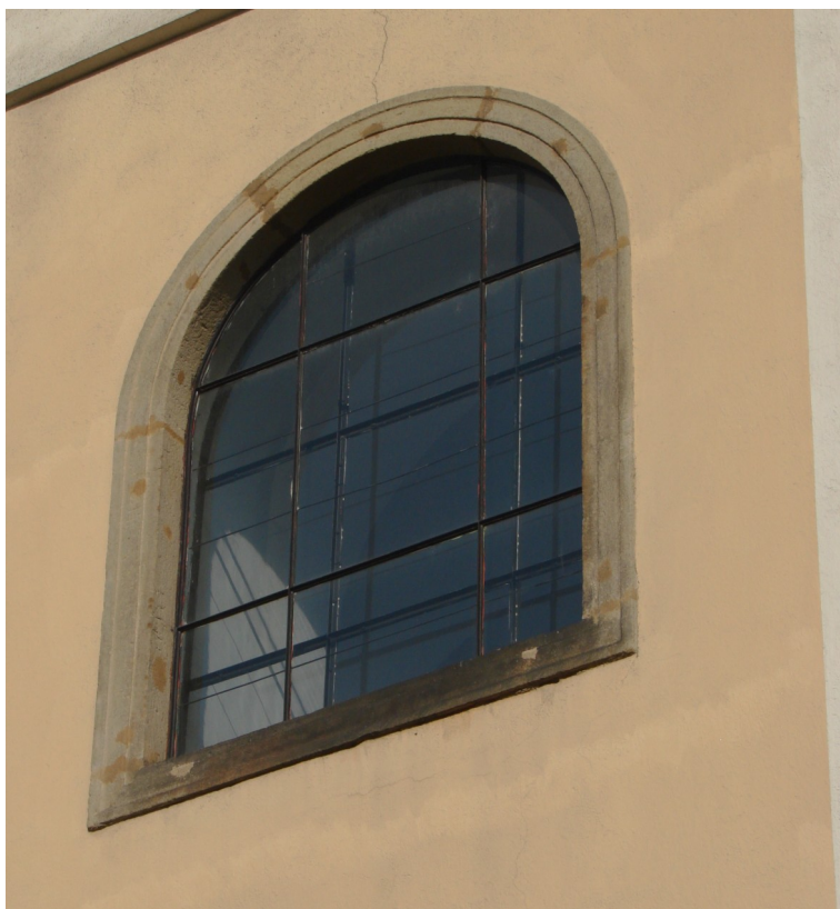
Pískovcové ostění okna na jižní straně kostela, první okno od východního nároží.
