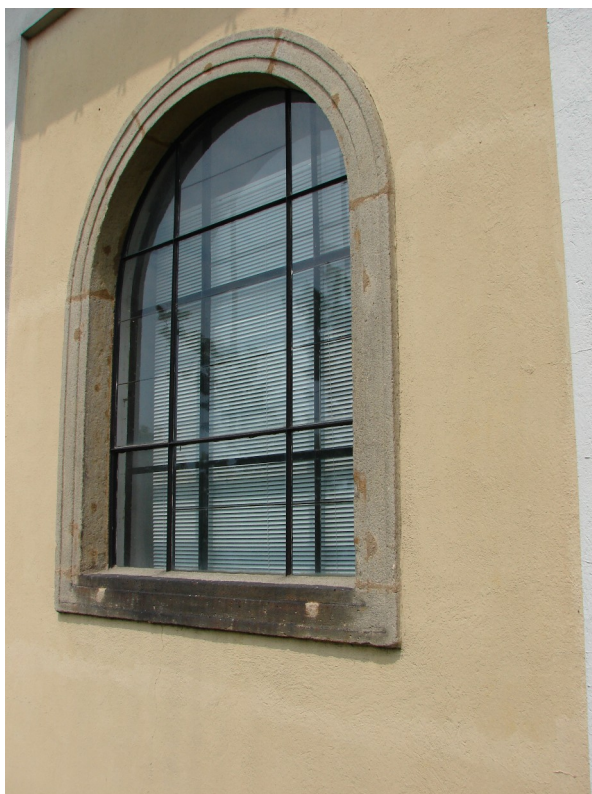
Pískovcové ostění okna na jižní straně kostela, čtvrté okno od východního nároží.
