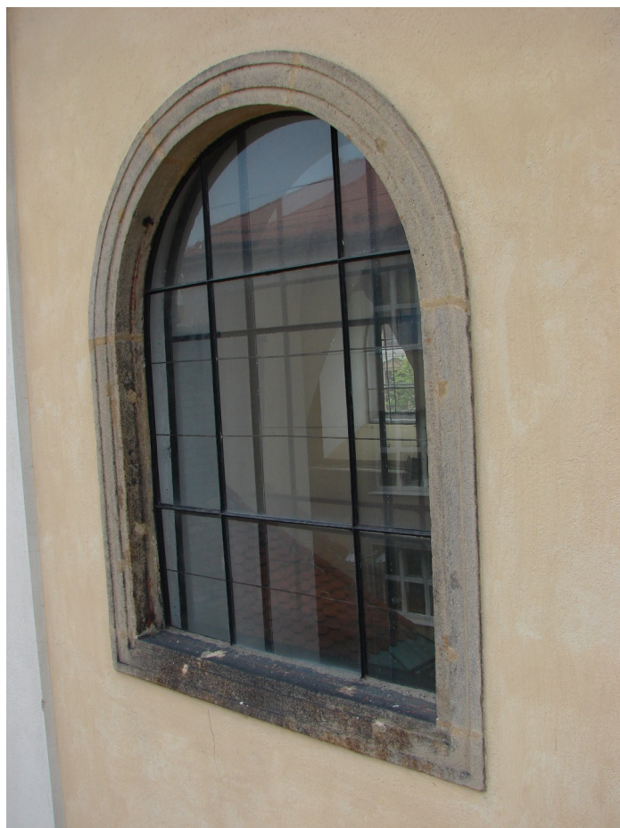
Pískovcové ostění okna na severní straně kostela, (třetí okno od nároží).
