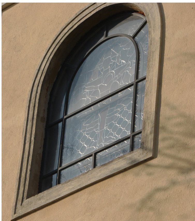
Pískovcové ostění okna na východní straně kostela, (druhé okno od zákristie).
